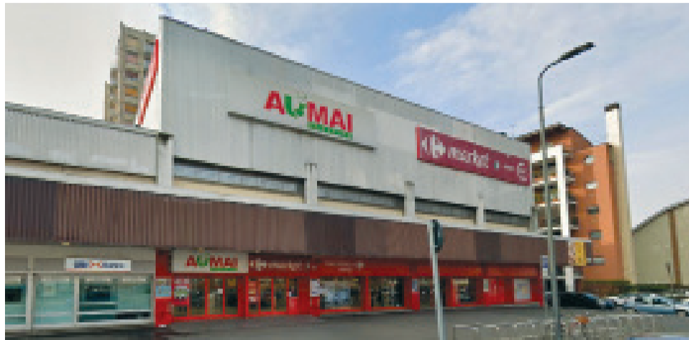
L'edificio in via Dei Missaglia, sede fino a poche settimane fa di Carrefour e Aumai (e prima ancora di una banca), dove potrebbe essere realizzata la Casa di Comunità del quartiere.
