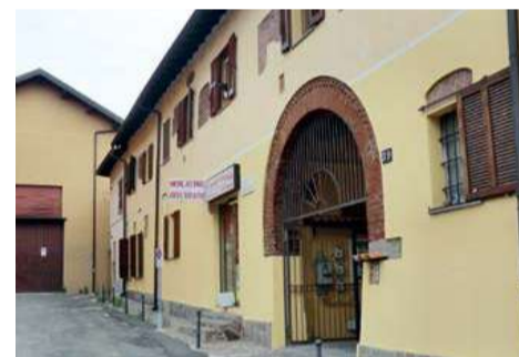
L'edificio sede del monastero di San Barnaba in Gratosoglio.
