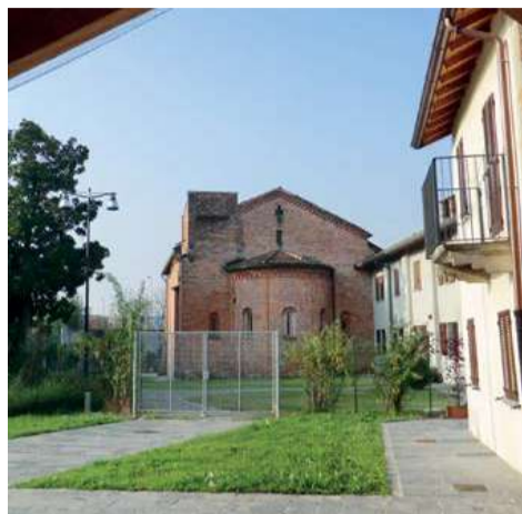
Santa Maria alla Fonte, la Chiesa Rossa risalente al XIV secolo.
