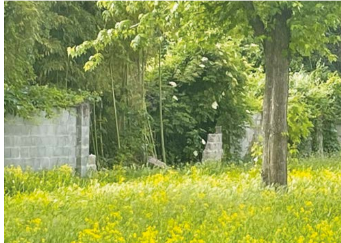
Il muro sfondato dell'ex fabbrica da cui entrano e escono gli occupanti.
